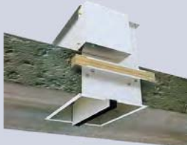
CORTAFUEGO EN FORJADO
